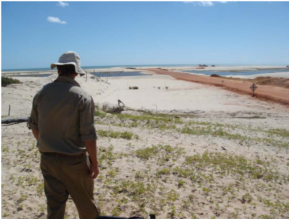
ILUSTRAÇÃO 8 - O ATERRO PARA IMPLANTAÇÃO DA ESTRADA SE FEZ INCLUSIVE ATRAVESSANDO LAGOAS.
