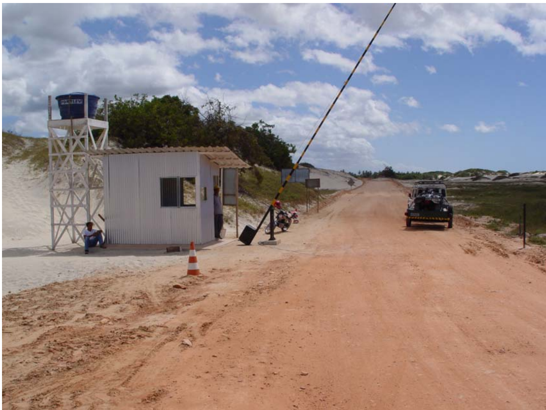
ILUSTRAÇÃO 6 - ESTRADA DE ACESSO AO LOCAL DE IMPLANTAÇÃO DO EMPREENDIMENTO
